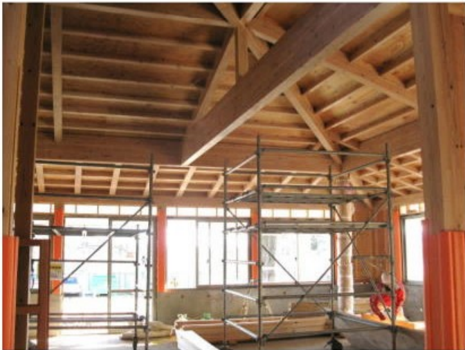
保健室 (入り口側から校庭側 見て) 側
