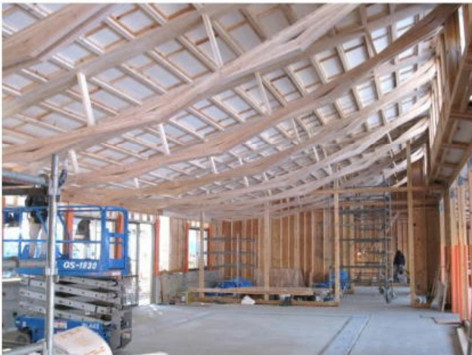
職員室 (廊下東側入口から)
