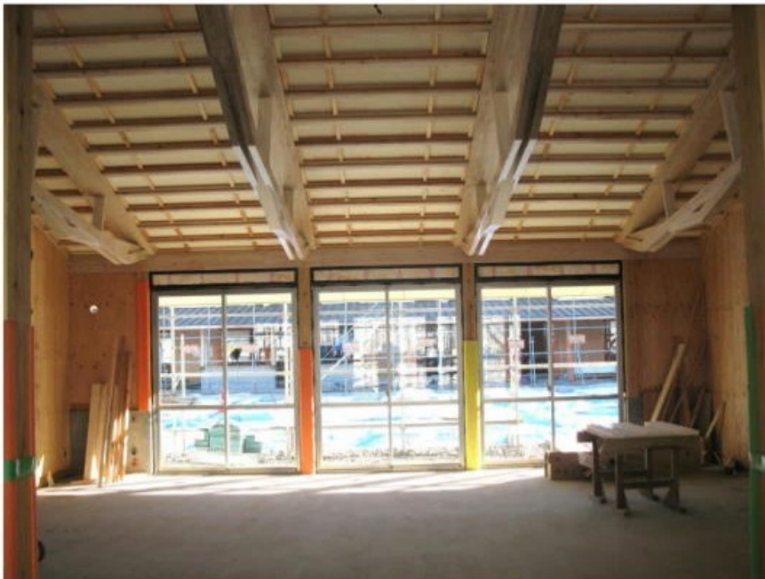
普通教室 (廊下側から、緑地・ 広場を見て)
